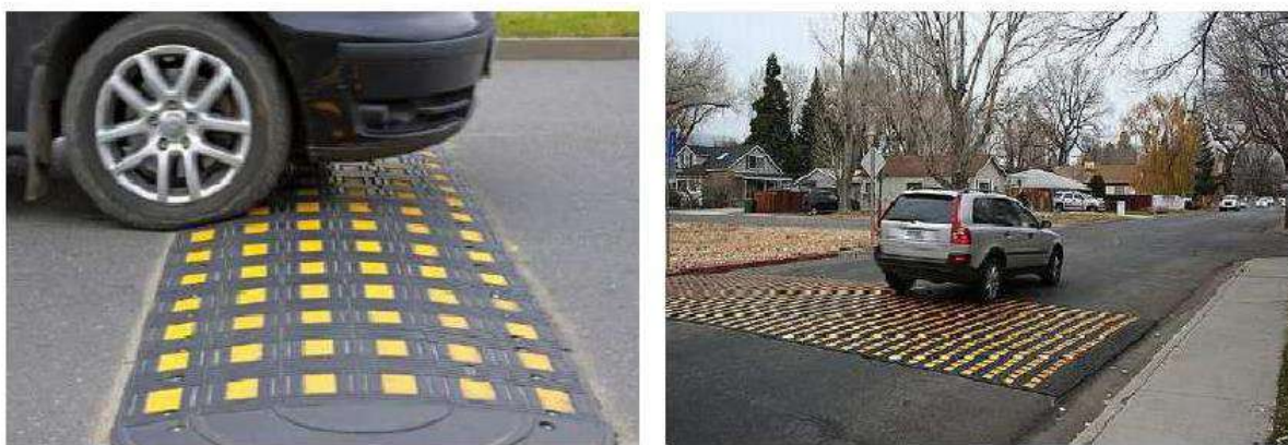
Figura 6-5: Dispositivi di moderazione verticale: dossi stradali artificiali.
